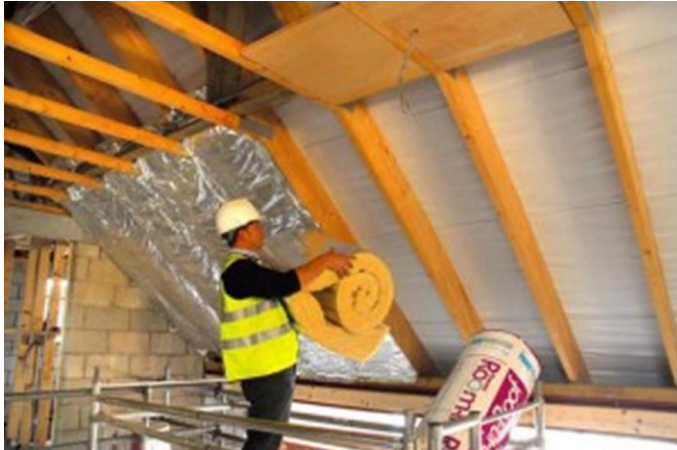
Figuur 2.6 Dakisolatie met wol tussen de balken
