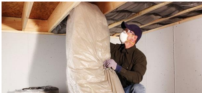
Figuur 2.5 Kruipruimte isoleren (bron: www.isolatie.net )
